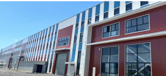
2024年9月上杭智造中心年产能达6GWh储能系统,一期项目投产年产能达2GWh
