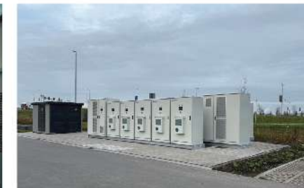
Centro de Jardinería, Países Bajos Capacidad: 1MW / 2.2MWh Aplicación: Autoconsumo Solar
