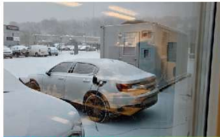
Estación de Carga para VE, Suecia Capacidad: 500kW / 504kWh Aplicación: Respuesta a la Demanda
